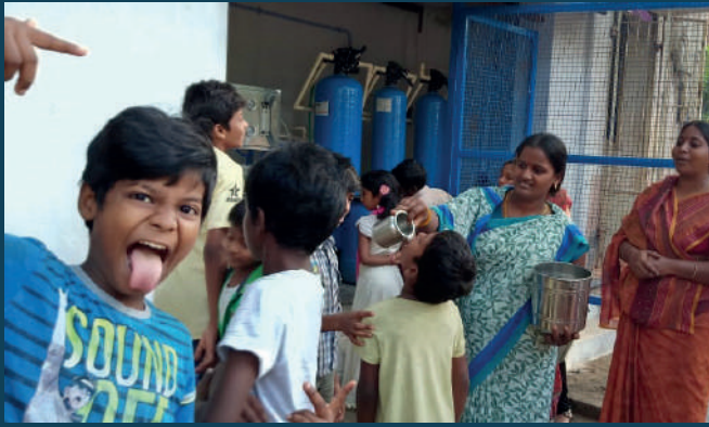
Die neuen Wasserfilter sind installiert und sorgen für frisches Wasser und Freude ;)
